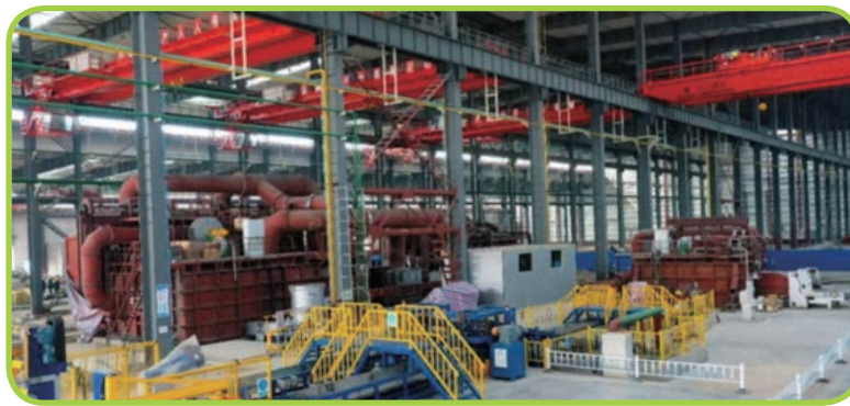
中德宏順疫情期間正在緊張施工
