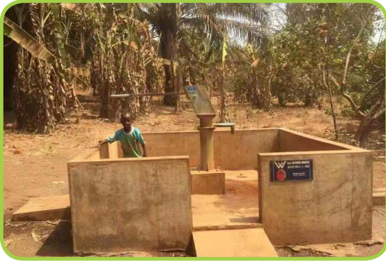
贏聯盟投資興建水井
